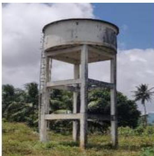
**Figura 68** - Reservatório elevado desativado próximo ao encontro das BR-101 e 406 (Olho d'Água do Carrilho).
