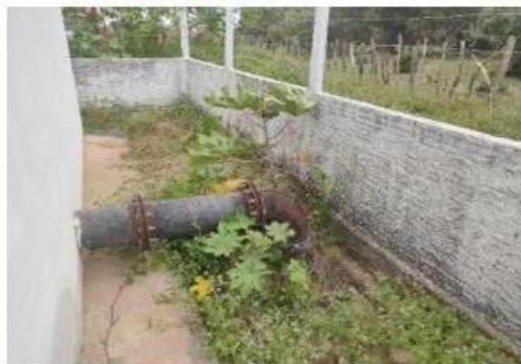
**Figura 64** - Detalhe da tubulação de recalque de saída da elevatória.
