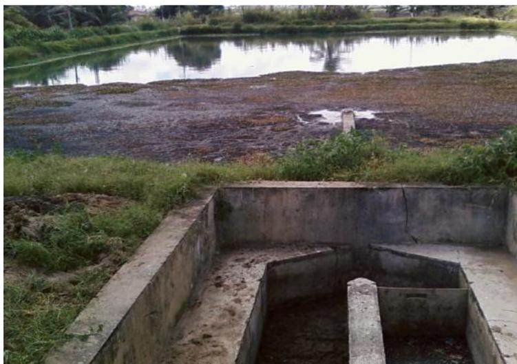
**Figura 88** - ETE-Regomoleiro II. Vista das caixas de areia e da canalização de entrada na lagoa.
