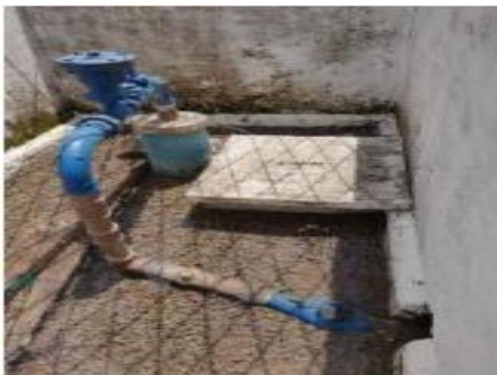
**Figura 67** - Vazamento na unidade de captação do loteamento Jardim Botânico.
