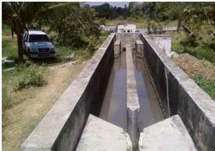
**Figura 87** - Vista superior de gradeamento e caixa de areia, com os esgotos brutos sendo recalcados diretamente pelas bombas.
