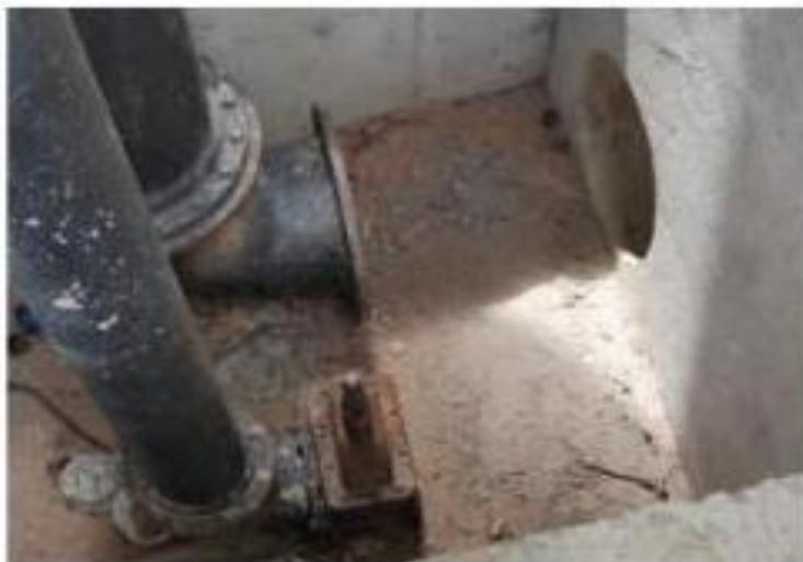
**Figura 66** - Detalhe das tubulações de extravasor e de limpeza do REL Jardim Petrópolis.
