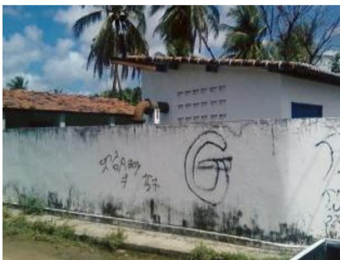
**Figura 85** - Elevatória EE-Regomoleiro. Vista externa da unidade, que não dispõe de gradeamento e caixa de areia.
