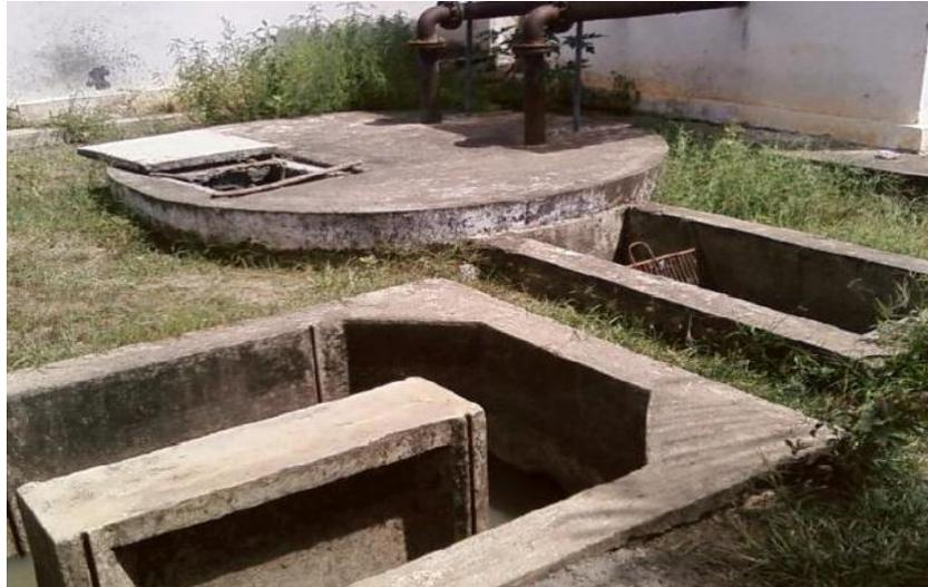
**Figura 84** - Elevatória EE-Santo Antônio. Vista da grade e canal de entrada do esgoto bruto e canais da caixa de areia, ao fundo, o poço de sucção.
