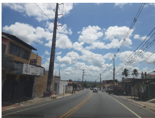
Figura 39 – Ocupação da Faixa de Domínio da RN-160.
