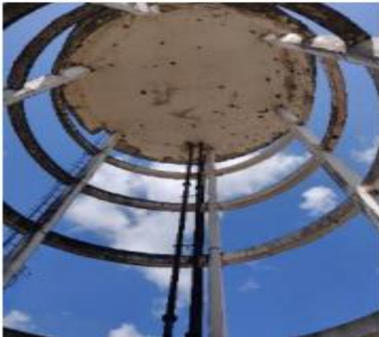
Figura 74 – EL Santo Antônio (Rua Otávio Augusto Barbosa) com detalhe da estrutura em concreto armado apresentando patologias.
