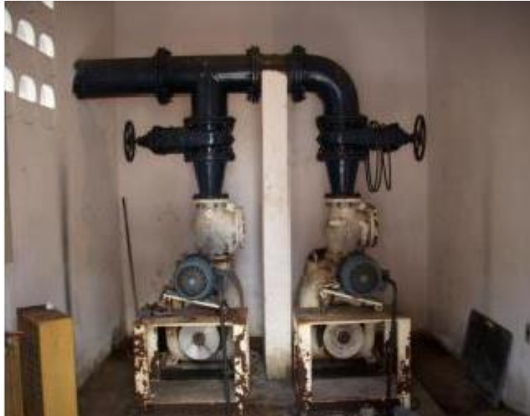
Figura 84 – Bombas que recalcam o esgoto bruto.
