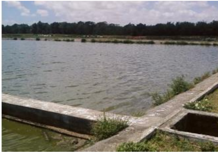
Figura 86 – ETE-Regomoleiro I. Vista da primeira lagoa.
