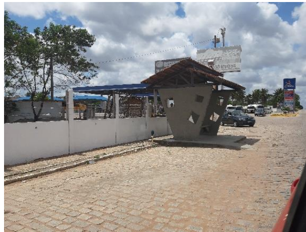
Figura 47 – Abrigo municipal em alvenaria com cobertura colonial.
