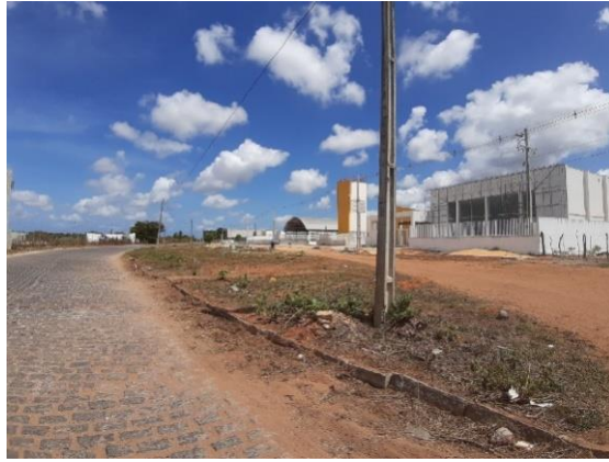
Figura 45 – Ausência de passeio público no novo polo educacional.
