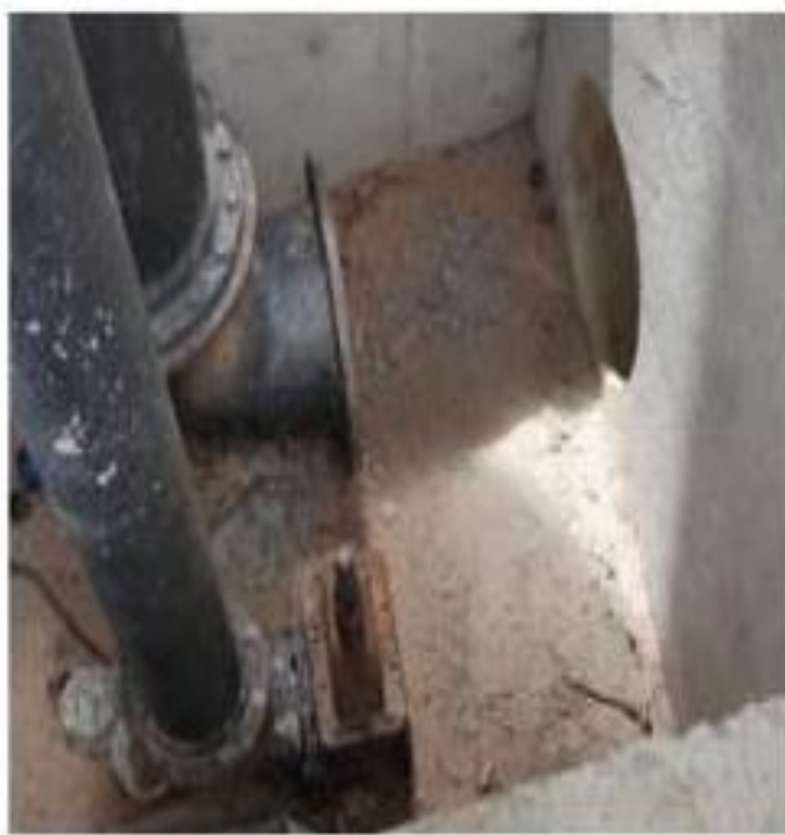
Figura 66 – Detalhe das tubulações de extravasor e de limpeza do REL Jardim Petrópolis.
