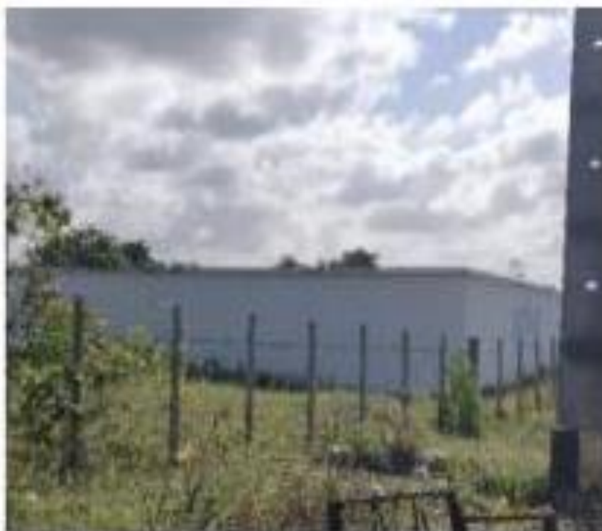
Figura 72 – Vista geral do RAP Aeroporto.
