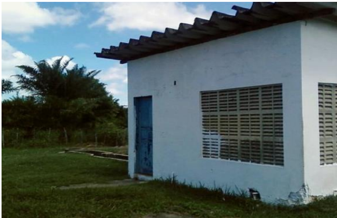
Figura 79 – Elevatória EE-3 para a ETE Sede - Vista da unidade, canal de entrada do esgoto bruto e caixa de areia.
