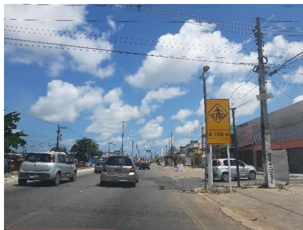
Figura 41 - Sinalização Vertical de Advertência.
