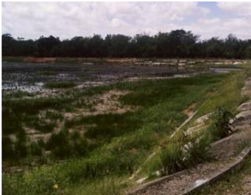
Figura 87 – 2ª lagoa, paralisada por rompimento do talude lateral, em reparos.
