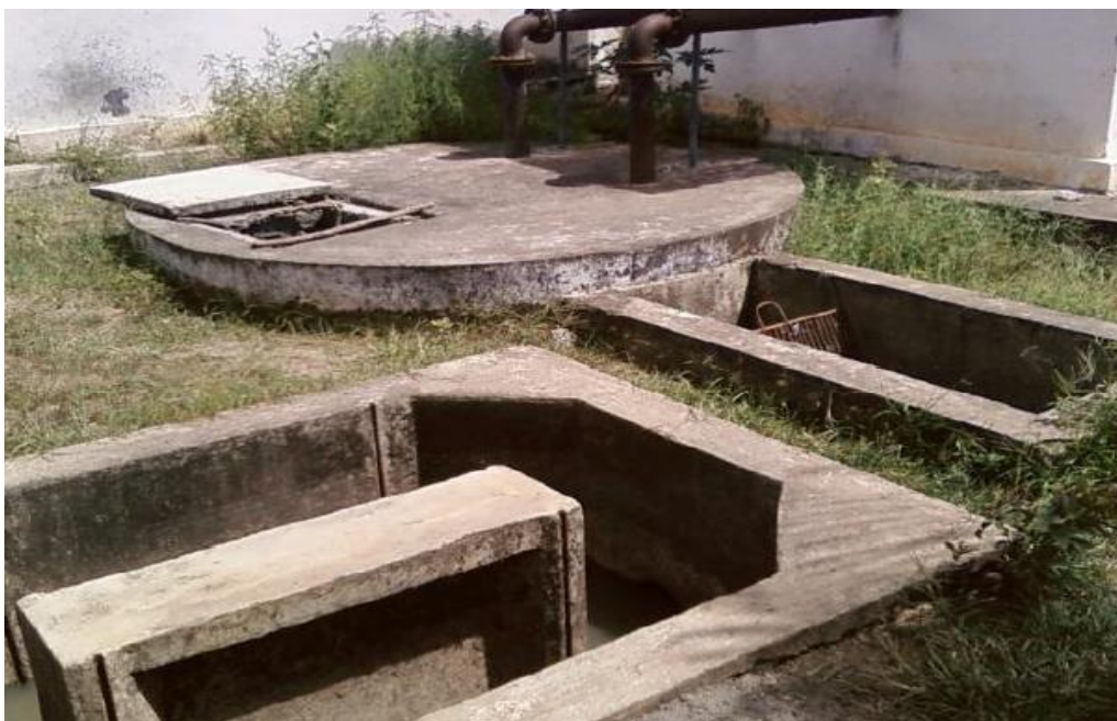
Figura 82 – Elevatória EE-Santo Antônio. Vista da grade e canal de entrada do esgoto bruto e canais da caixa de areia, ao fundo, o poço de sucção.
