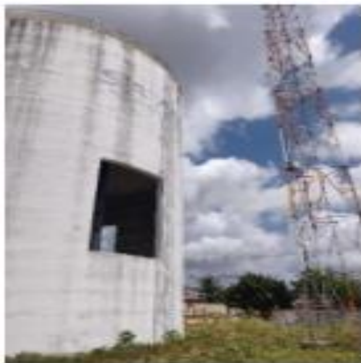
Figura 65 – Vista do REL Jardim Petrópolis para a rua Manoel Firmino.
