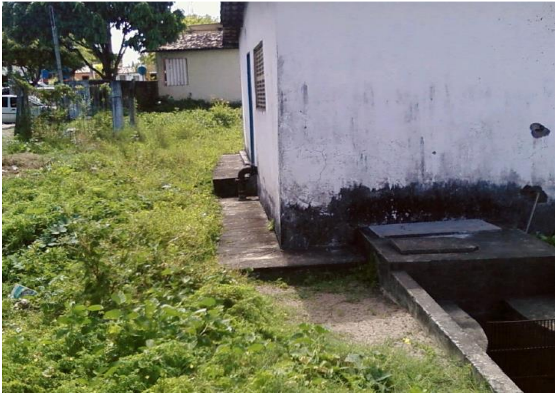
Figura 77 – Elevatória EE-1 (Sede) - Vista da unidade, canal de entrada do esgoto bruto e canais da caixa de areia.
