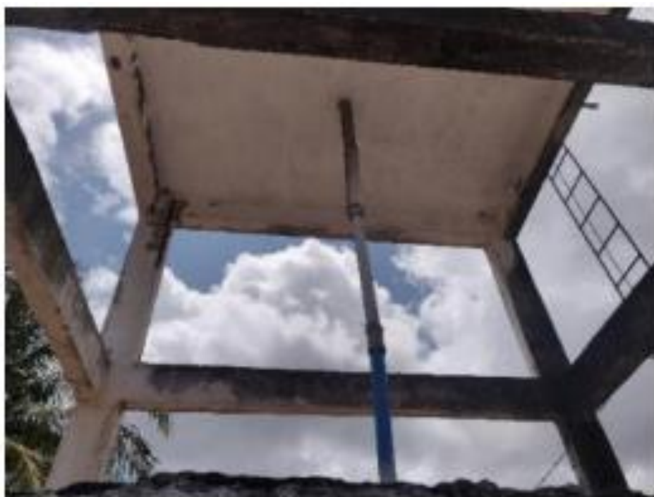
Figura 69 – Patologias no concreto observada em um reservatório elevado (PT 02 - Guajirú).
