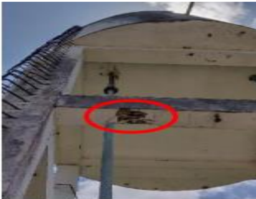
Figura 76 – Detalhe de patologia no concreto armado do REL Poti Cavalcante (centro de operações - CO - do SAAE).
