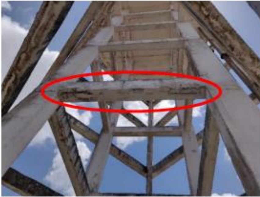
Figura 75 – Armadura aparente com corrosão em viga do REL Santa Terezinha.
