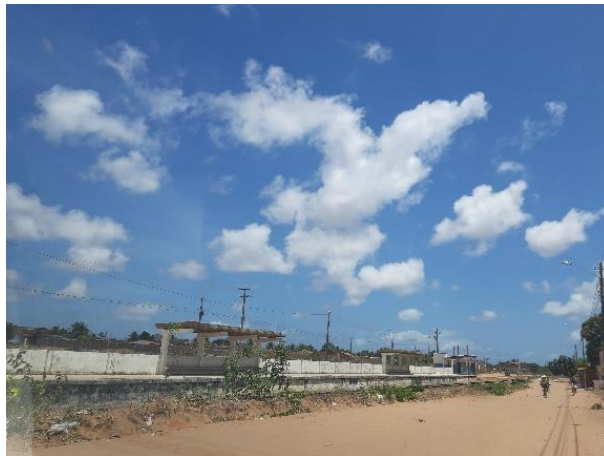
Figura 49 – Estação Nordelândia localizada no bairro Lagoa Azul.
