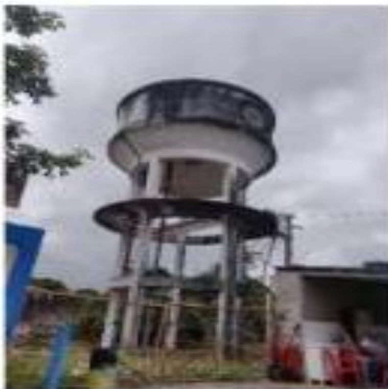
Figura 71 – Reservatório elevado da CAERN desativado no bairro Amarante.
