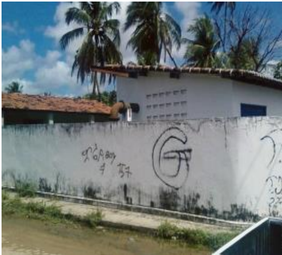
Figura 83- Elevatória EE-Regomoleiro. Vista externa da unidade, que não dispõe de gradeamento e caixa de areia.
