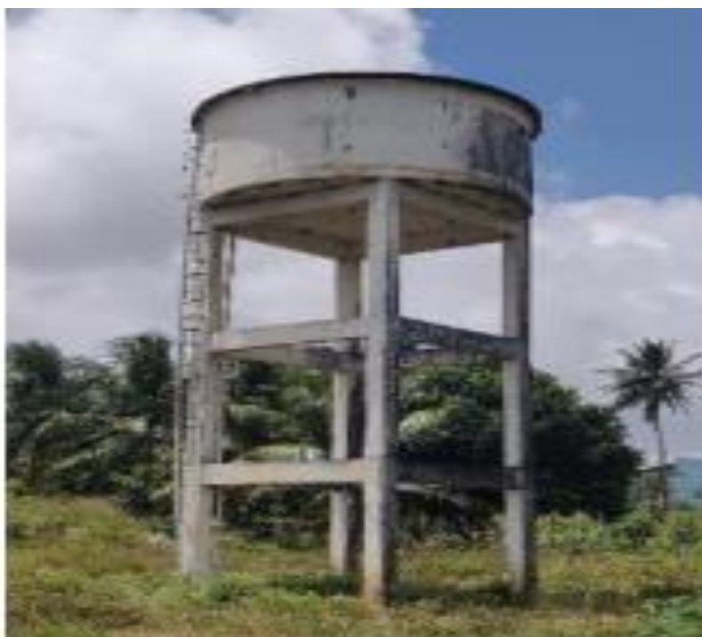
Figura 68 – Reservatório elevado desativado próximo ao encontro das BR-101 e 406 (Olho d'Água do Carrilho).
