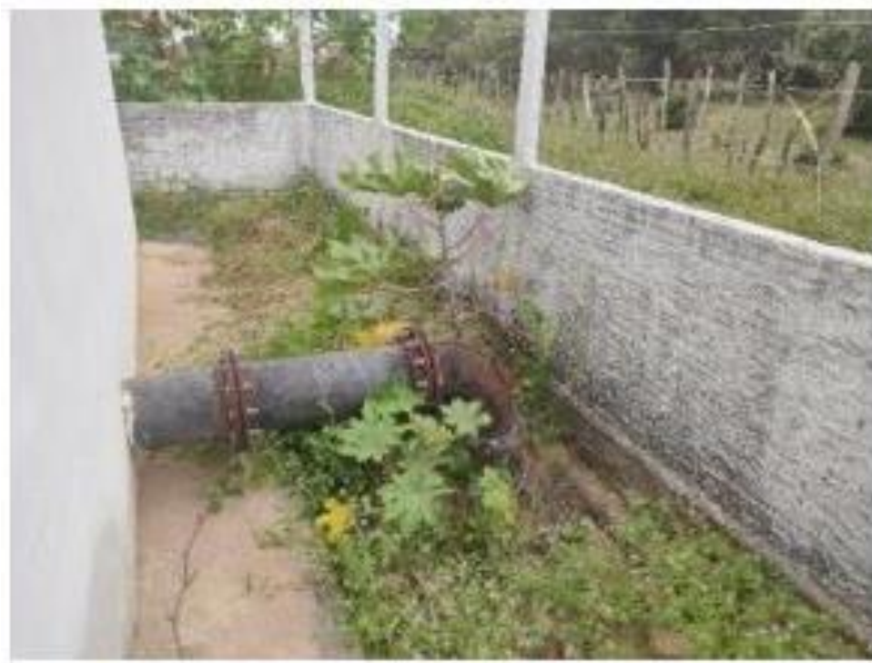
Figura 64 – Detalhe da tubulação de recalque de saída da elevatória.
