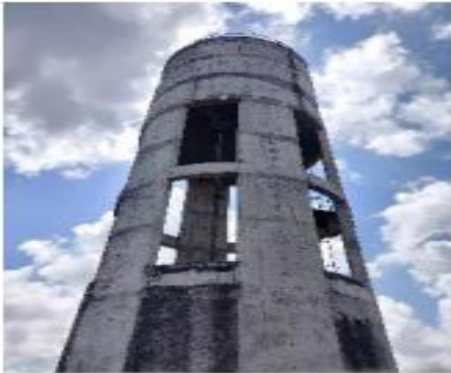
Figura 73 – REL loteamento Santa Beatriz sem pintura.
