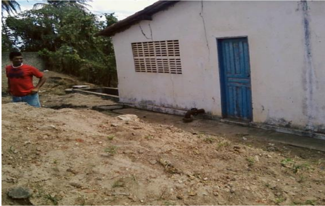
Figura 78 – Elevatória EE-2 (Sede) - Vista da unidade, canal de entrada do esgoto bruto e canais da caixa de areia.
