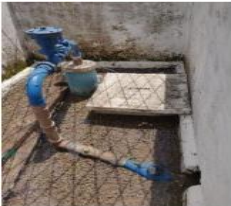
Figura 67 – Vazamento na unidade de captação do loteamento Jardim Botânico.
