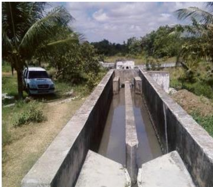
Figura 85 – Vista superior de gradeamento e caixa de areia, com os esgotos brutos sendo recalcados diretamente pelas bombas.
