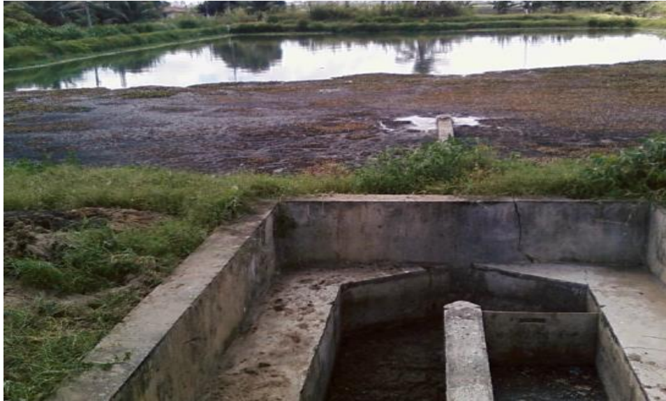
Figura 88 – ETE-Regomoleiro II. Vista das caixas de areia e da canalização de entrada na lagoa.
