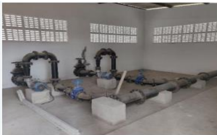
Figura 63 – Interior da estação elevatória Cidade das Flores.
