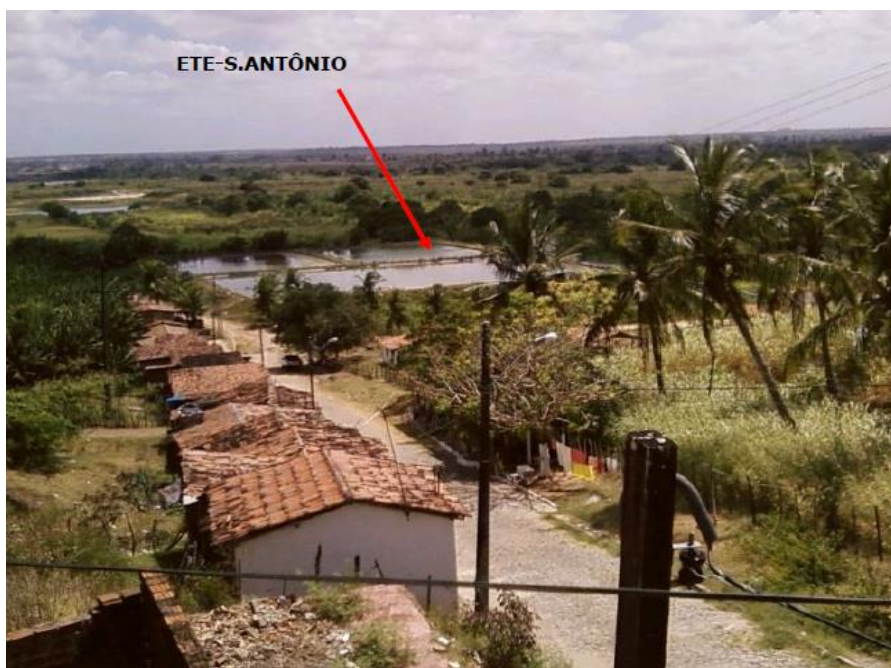
Figura 81 – ETE-Santo Antônio. Ao fundo, vista geral da unidade.
