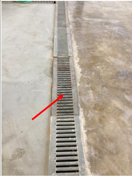
Figura 23: Central de Resíduos Sólidos do Aeroporto. Detalhe para as canaletas para efluentes de lavagem.
