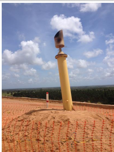
Figura 37: Chaminé de queima do gás das células do Aterro Sanitário.
