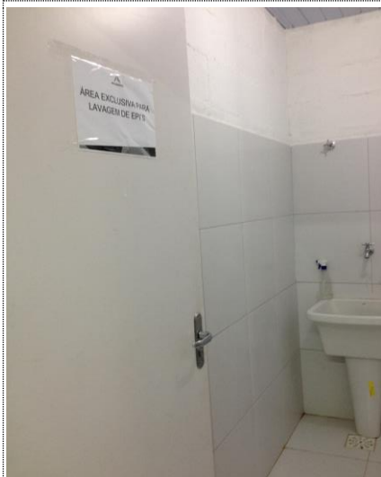
Figura 31: Central de Resíduos Sólidos do Aeroporto. Área de lavagem e manuseio de EPI.
