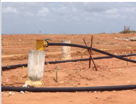
Figura 38: Tubulação de coleta de gás para usina de biogás.
