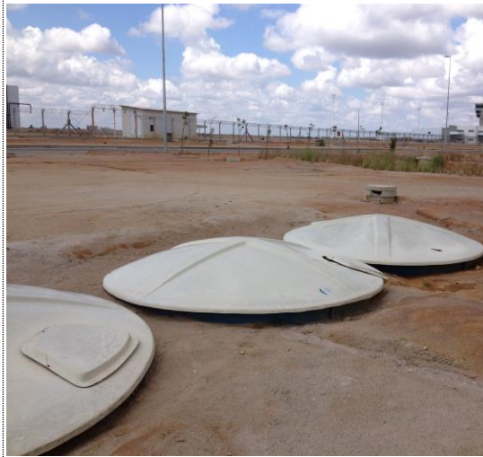
Figura 24: Central de Resíduos Sólidos do Aeroporto. Detalhe para as caixas coletoras e armazenadores de Efluentes.
