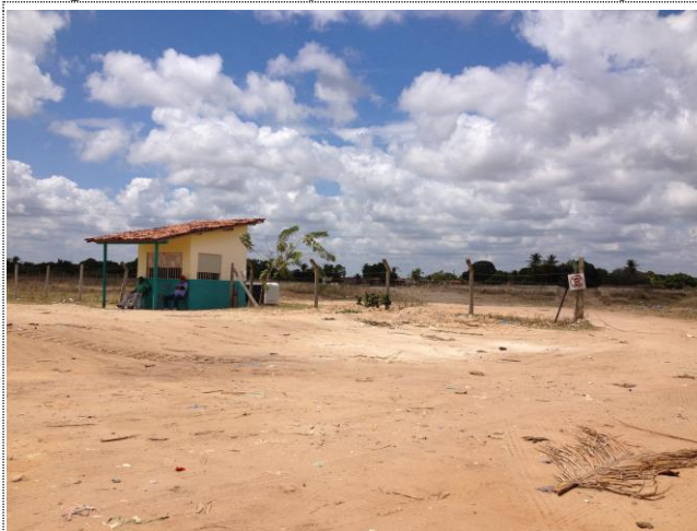
Figura 42: Vista da portaria do Aterro Guajiru.
