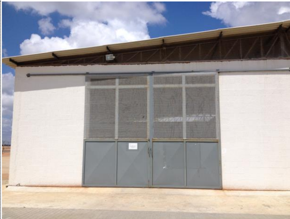
Figura 19: Central de Resíduos Sólidos do Aeroporto Internacional Gov. Aluísio Alves.
